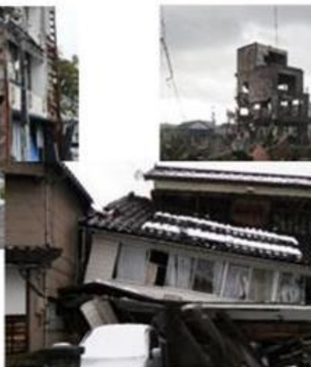
木造建築物の倒壊状況（穴水町）
